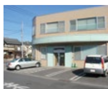
野木病院 / 透析室 栃木県下都賀郡野木町友沼 5320-2
